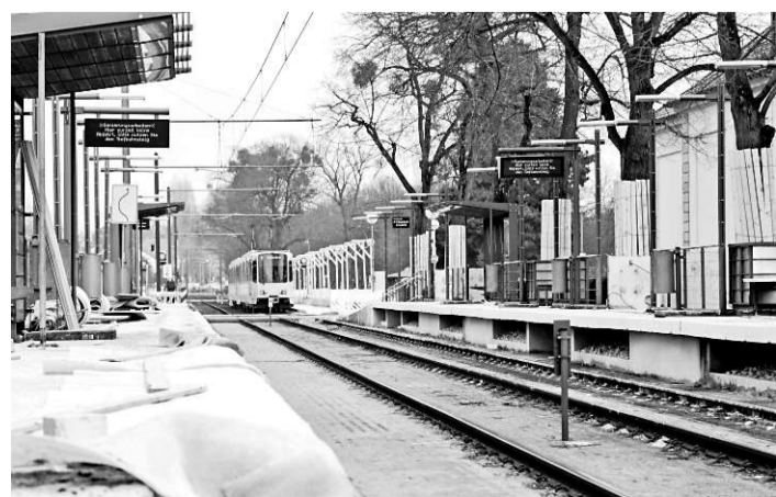
SANIERUNGSFALL: Der Hochbahnsteig der Station Herrenhäuser Gärten wird bis Juni wegen Frostschäden erneuert.
